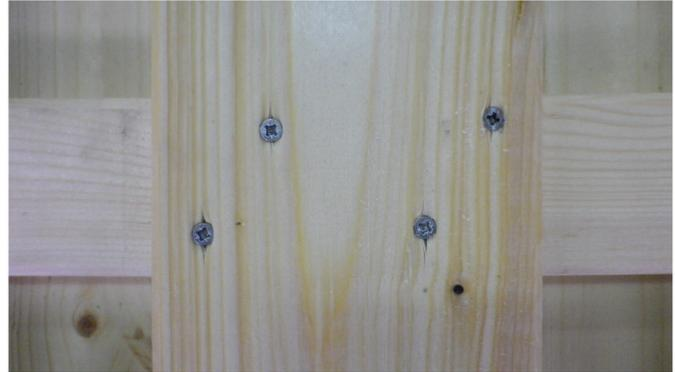
Die beiden losen Bretter werden oben und unten an der Querlatte mit je 4x Schrauben fixiert, mittig mit 1x Schraube
